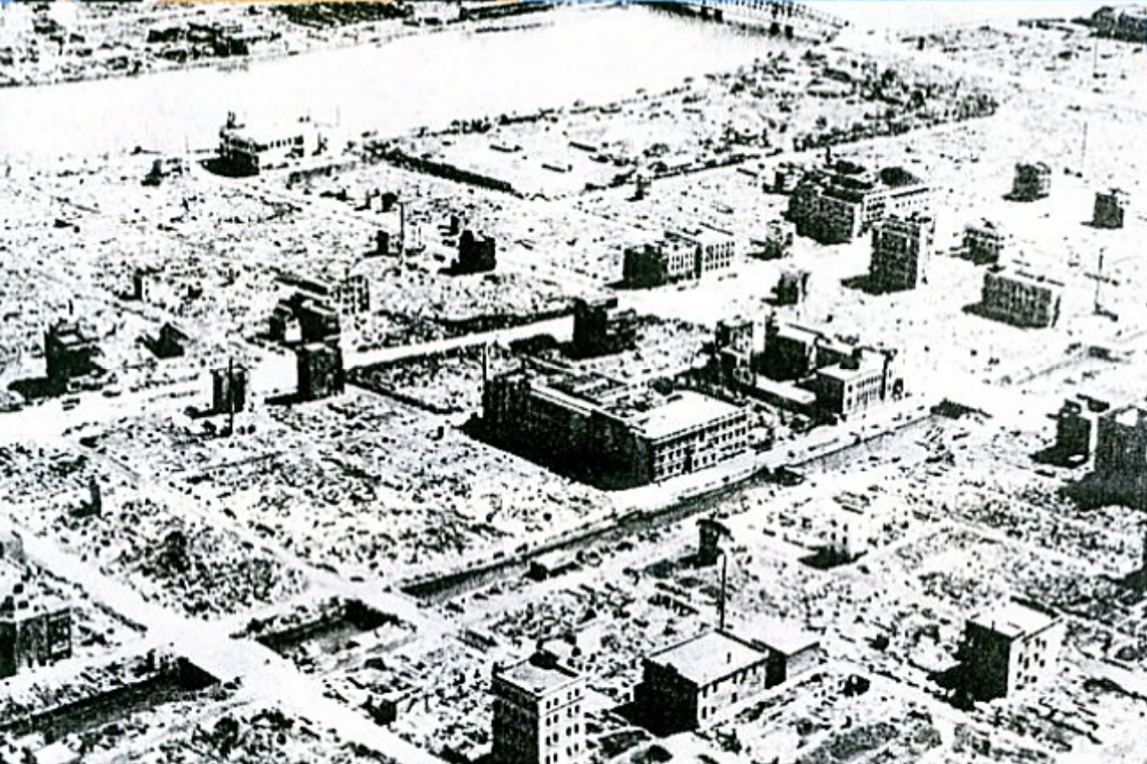
日本橋浜町付近
